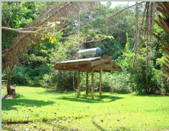
Figura II-78: Sistema solar para aquecimento de água
